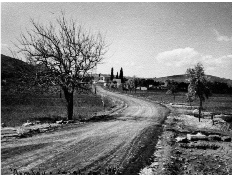
Εικ. 1. Σαλαμίνα, Αμπελάκι. Αποψη (από τα ανατολικά) τμήματος της δημόσιας Οδού Ελ. Βενιζέλου, ως χωματόδρομοι, με κατεύθυνση προς το κέντρο του χωριού (προς τα δυτικά), σε φωτογραφία του Νικολάου Μπρούζου του 1956. Στον μέσον, διακρίνεται το εκκλησίδιο του Αγίου Ιωάννου του Προδρόμου, ενώ αριστερότερα, στο βάθος του δρόμου, υπολογίζεται το σημείο της εύρεσης του θησαυρού των χρυσών νομισμάτων (Μιθριδράτης;). (Προσθήκη Σύνταξης).
